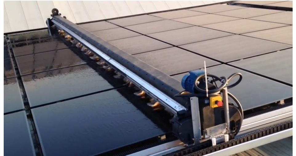
SISTEMA DE LIMPIEZA FIJO
